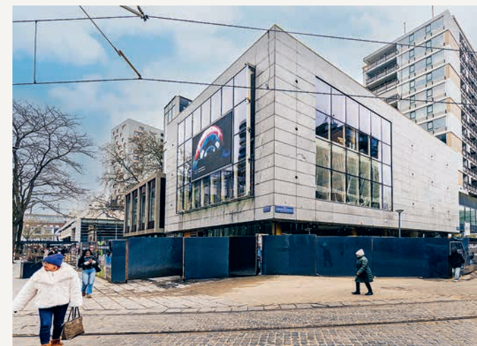
De huidige status op de bouwlocatie in het centrum van Rotterdam.
